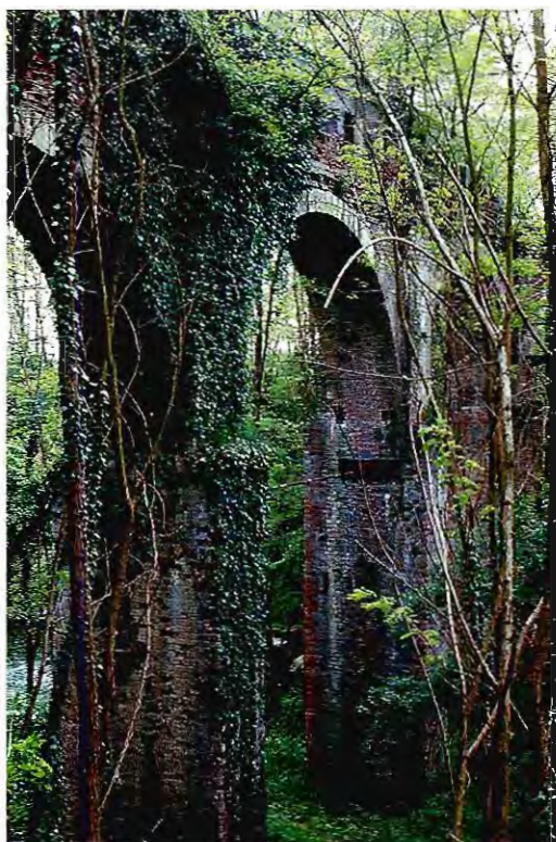
Scorcio delle strutture della "Macchina idraulica".
